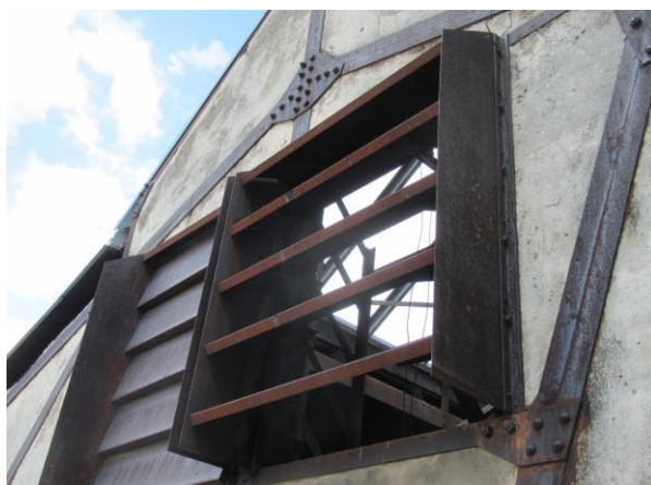
Kompresorovna, severní fasáda s detailem nasávacího otvoru a štít s žaluziovým oknem
