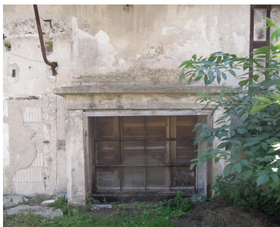
Kompresorovna, severní fasáda s detailem nasávacího otvoru a štít s žaluziovým oknem
