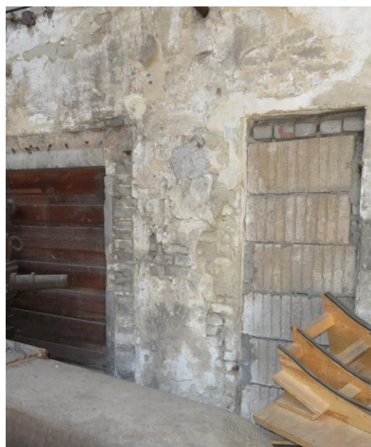
Kompresorovna, severní stěna – pohled k západu + detail nasávacího otvoru a nevhodná zazdívká
