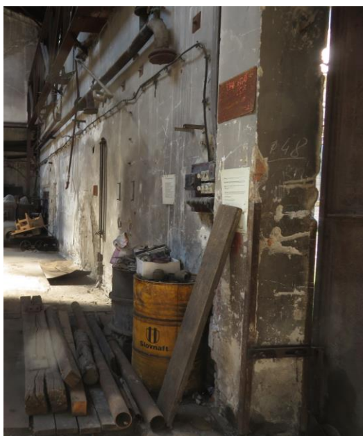
Kompresorovna, severní stěna – pohled k západu + detail nasávacího otvoru a nevhodná zazdívká
