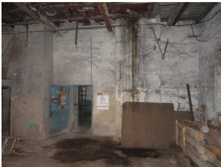
Jámová budova, 1. NP + detail prasklin s uhelným prachem
